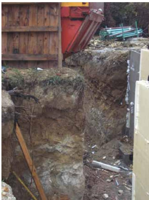
Abb. 2-1: Baugrube mit Bodenprofil
